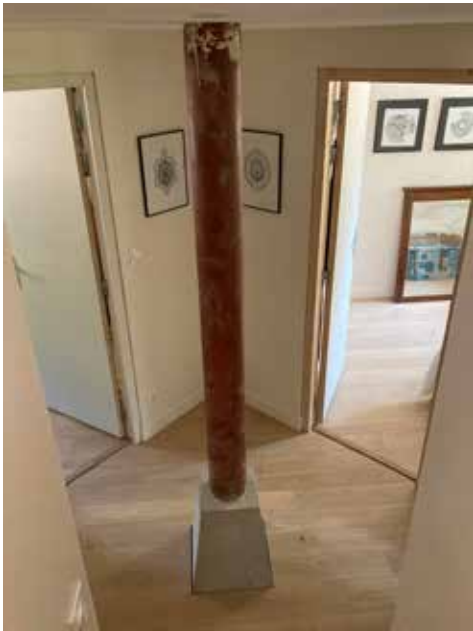
Le poteau métallique porteur est devenu élément de décoration au centre du palier du sous-sol.
