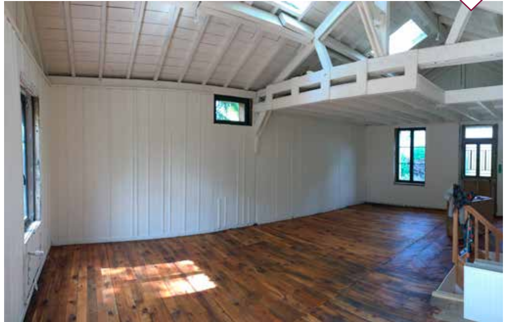
L'ancien lambris a été conservé et uniformisé par du blanc. Le parquet d'origine a été rénové.
