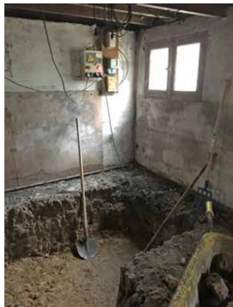
Le décaissement du sous-sol a permis de recréer des fondations solides et de gagner en surface habitable pour aménager des chambres.
