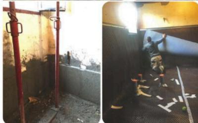
Pour créer son rez-de-jardin, Quentin a creusé le sol en deçà des fondations initiales. Il a utilisé un film drainant pour éviter les remontées d'eau et l'a recouvert d'une dalle flottante.
